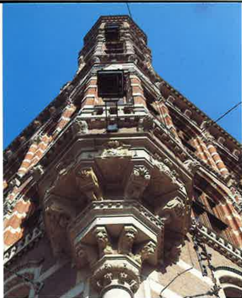
Magna Plaza, Amsterdam: herstel gevel en nieuwe functie (boven en links)
